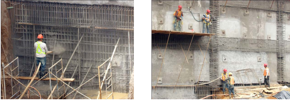
Fig. 4 Armado y lanzamiento de concreto.
