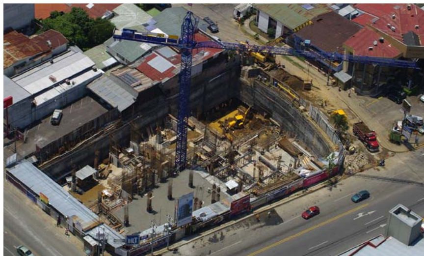
Fig. 6 Vista aérea de muro anclado.
