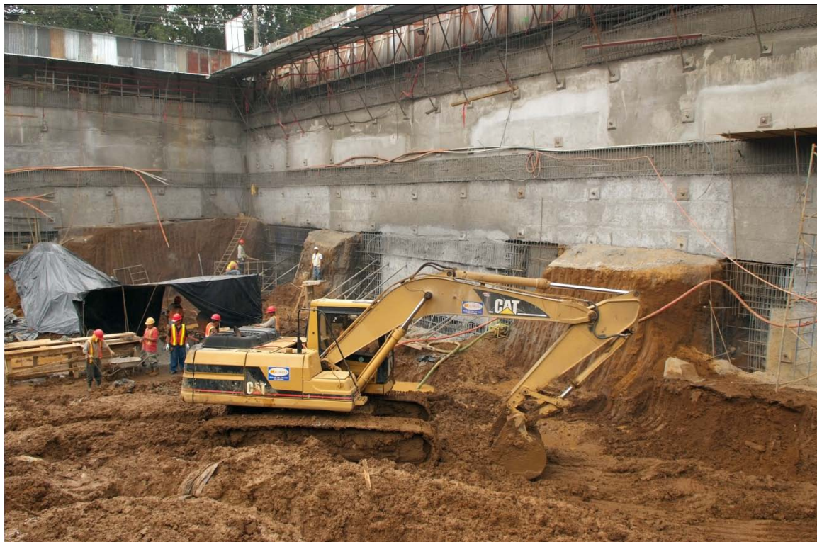
Fig. 2 Movimiento de Tierra para habilitar área para la perforación de anclajes
