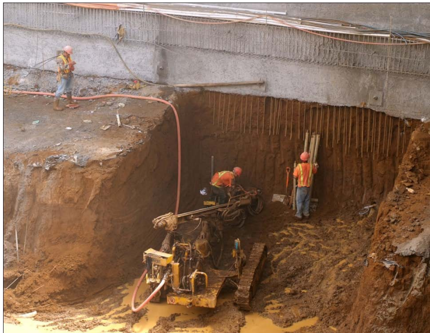
Fig. 3 Perforación de anclajes mediante el uso de equipo neumático.
