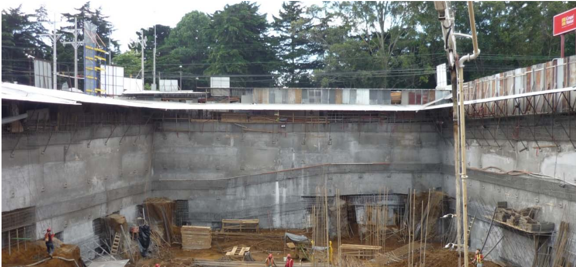
Fig. 1 Muro Anclado en proyecto ubicado en Sabana Oeste
