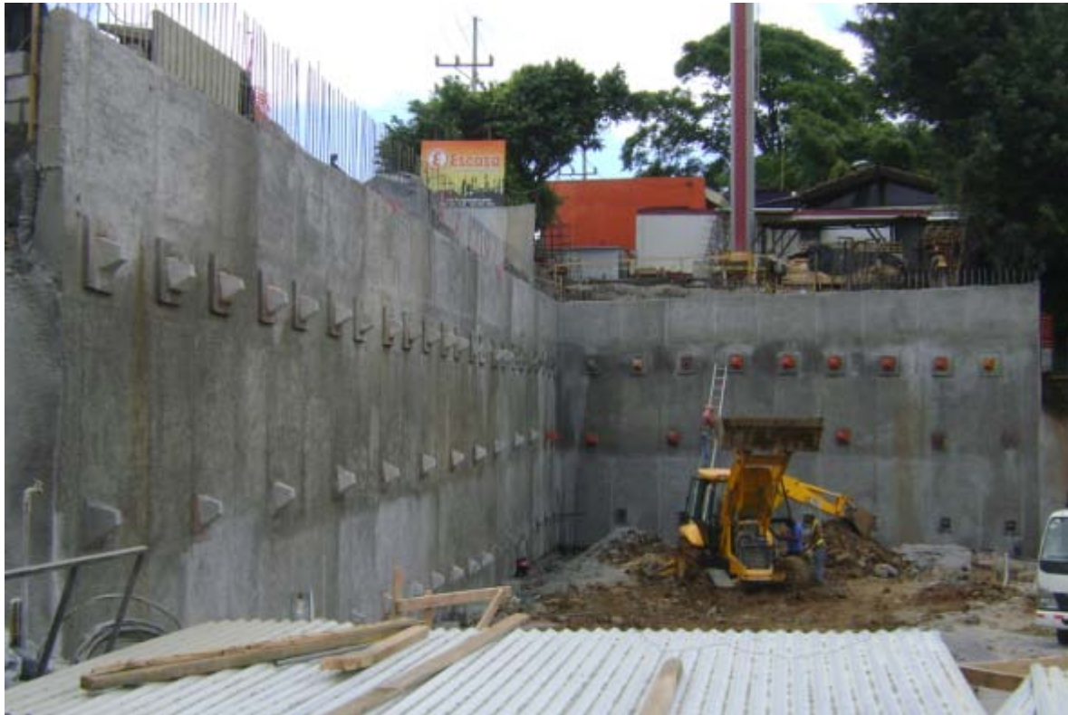
Fig. 7 Acabado de Muro con anclajes definitivos
