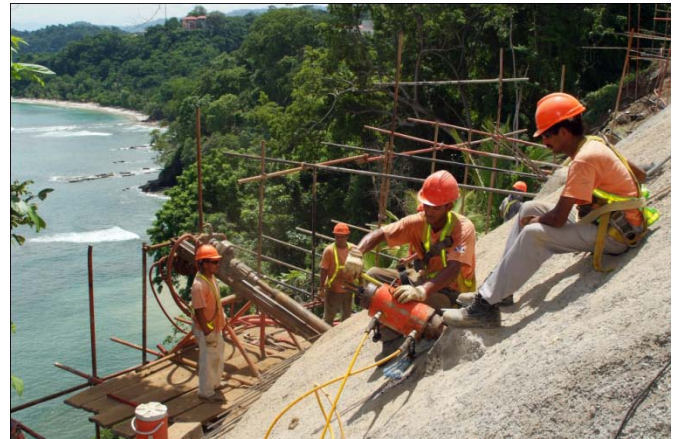
Fig. 5 Tensado de los anclajes.
